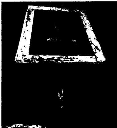
Para el aforo y toma de muestras se cuenta con una caja al final del sistema de tratamiento de aguas residuales no domésticas, que garantiza las condiciones para en cualquier momento de la operación realizar la medición de caudal y realizar análisis in situ de los parámetros de la Resolución 631 de 2015, así como la toma de muestras para su análisis en laboratorio.
