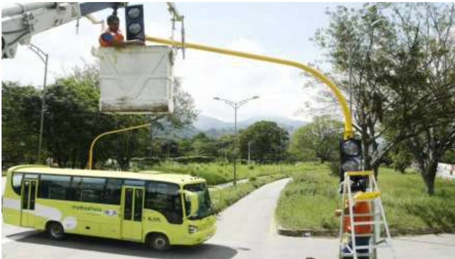
lustración 22. Instalación de semáforos en retornos autopista Floridablanca-Piedecuesta
