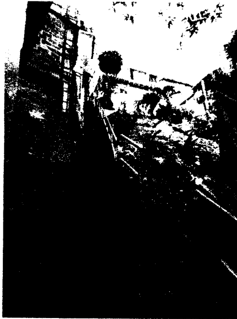
Fotografía 1. Perspectiva desde la parte baja del predio. Desarrollo urbanístico en zonas de alta pendiente.
