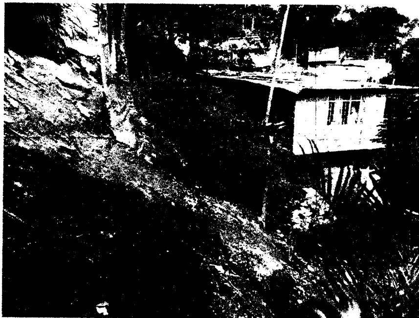
Fotografía 2. Predio sin cobertura vegetal de alta pendiente expuesto a procesos de infiltración y erosión laminar ocasionando humedades y problemas de estabilidad.
